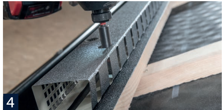
Juostą, per specialiai paruoštas tvirtinimo kiaurymes [1-6] 6 savisriegiais varžtais 4,8 x 35 per laštakį, tvirtiname prie gegnės.
